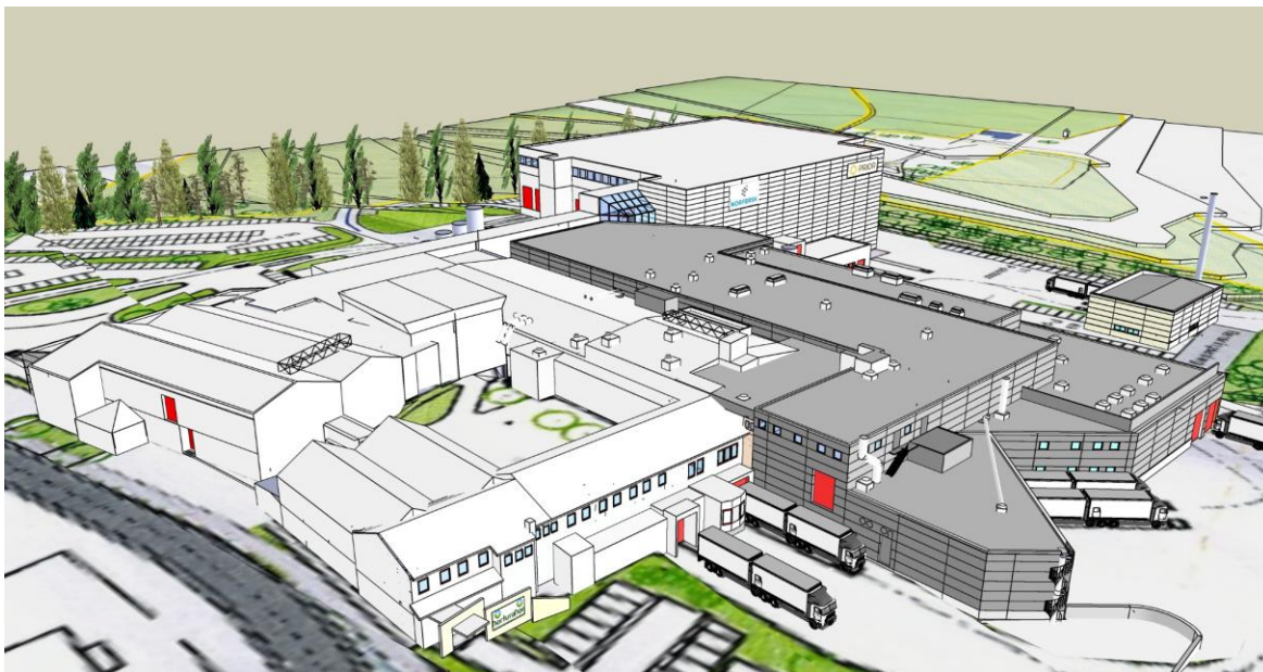
Norturas fabrikk på Hærland
